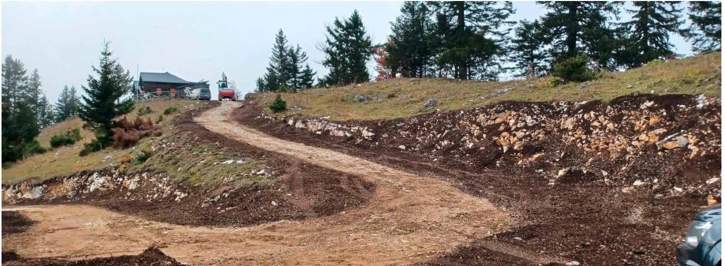
▲ Der neue Karrenweg kurz vor der Hütte – die ersten Schritte zur Begrünung sind getan
